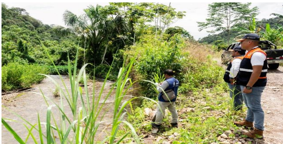
FIGURA N°02: SE OBSERVA LA SECCIÓN HIDRAULICA DEL RIO CUCHARA DISMINUIDO POR LA COLMATACIÓN DEL MATERIAL DE ARRASTRE
